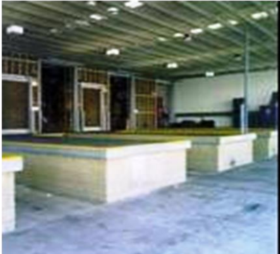
Figura 4. Banchine per il carico dei ponteggi e attrezzature per l'edilizia
